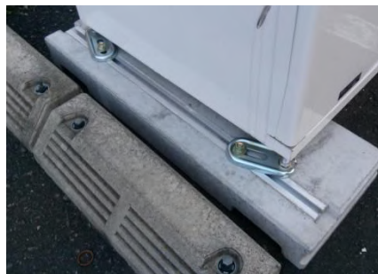
(b) Detalle de la conexión flexible
